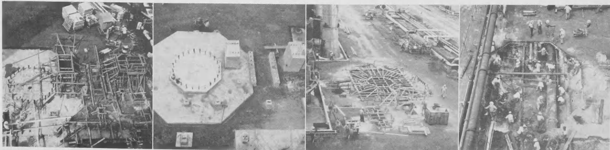
FUNDESHI PA seccionnan di e proyecto di difusion di calor ta muntrá den cuatro fase na Combination Units 5, 6, 7 y 8, di robez pa drechi. E cantidad total di concreto bashá den e fundeshinan na cada unidad, di 200 yarda cubico, di cual mas cu mitar ta pa e fundeshi di e schoorsteen. E otro plataforma di concreto lo wanta e compartimento di difusion di calor y un molina pa manda e gasnan pa e schoorsteen.
